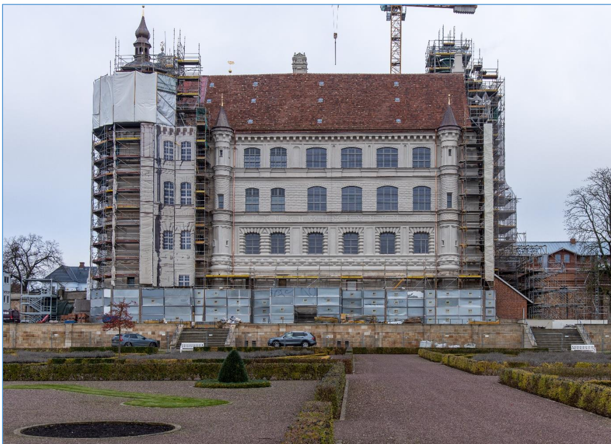
Güstrow (Lkr. ROS), Schloss, Südostfassade, erster abgerüsteter Fassadenabschnitt mit überarbeiteten und mit Lasuranstrichen versehenen Putzflächen, Dacheindeckung unter Wiederverwendung historischer Biber-schwanzziegeln, sanierten und teilweise rekonstruierten Schornsteinen © LAKD M-V/LD, S. Schöffbeck 2024.
