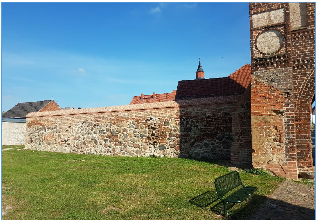
Altentreptow (Lkr. MSE), Mauerstraße, Stadtmauer, von Südwesten © LAKD M-V/LD, J. Schirmer 2023.
