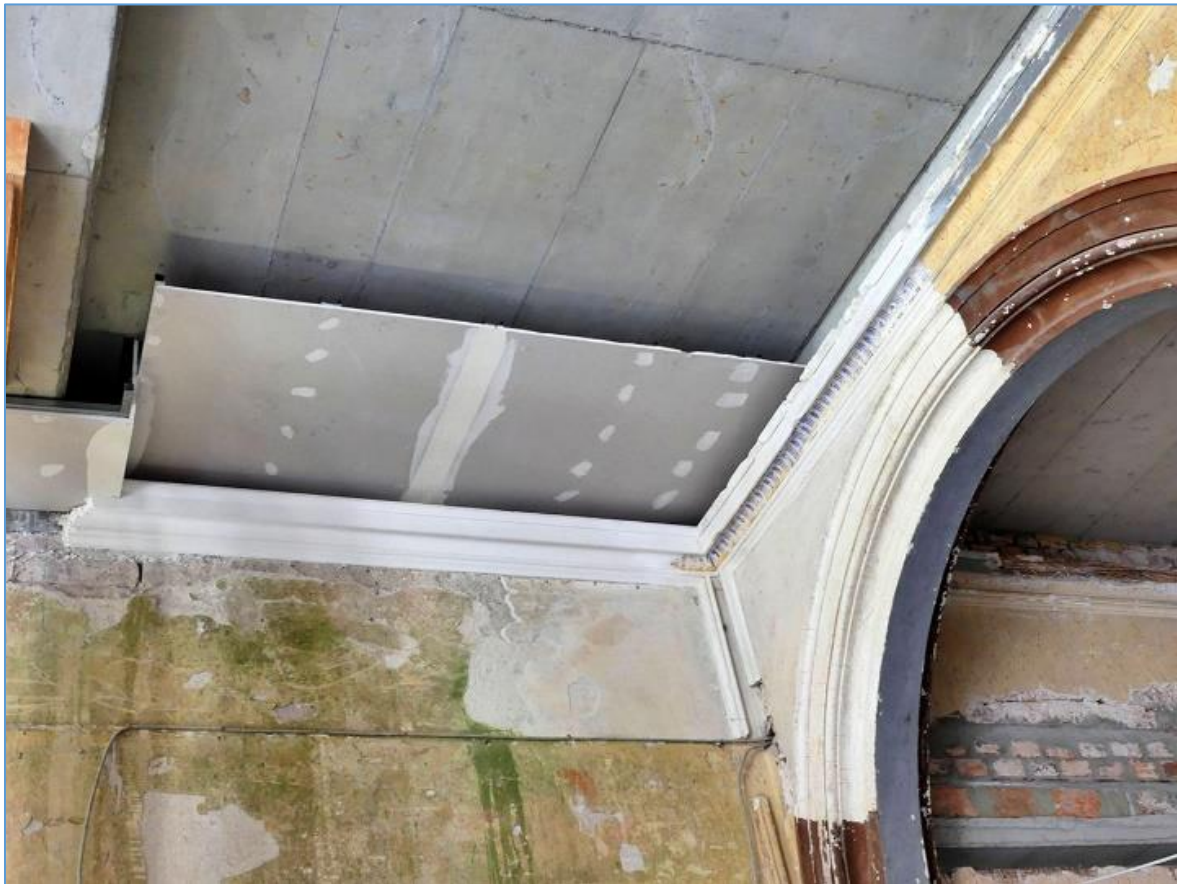
Broock (Lkr. VG), Gutshaus, Foyer, Stahlbetondecke am Übergang zur Wand mit Stülerschen Gestaltungselementen und Probefläche zur Deckenausbildung © LAKD M-V/LD, A. Krug 2023.
