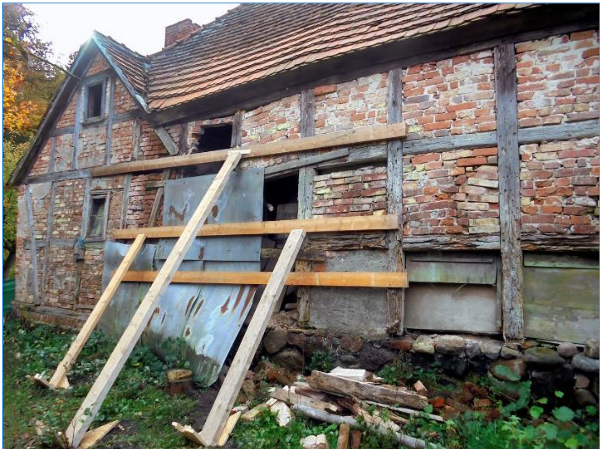
Neustrelitz (Lkr. MSE), Burg 3, Stallgebäude © LAKD M-V/LD, J. Schirmer 2022.
