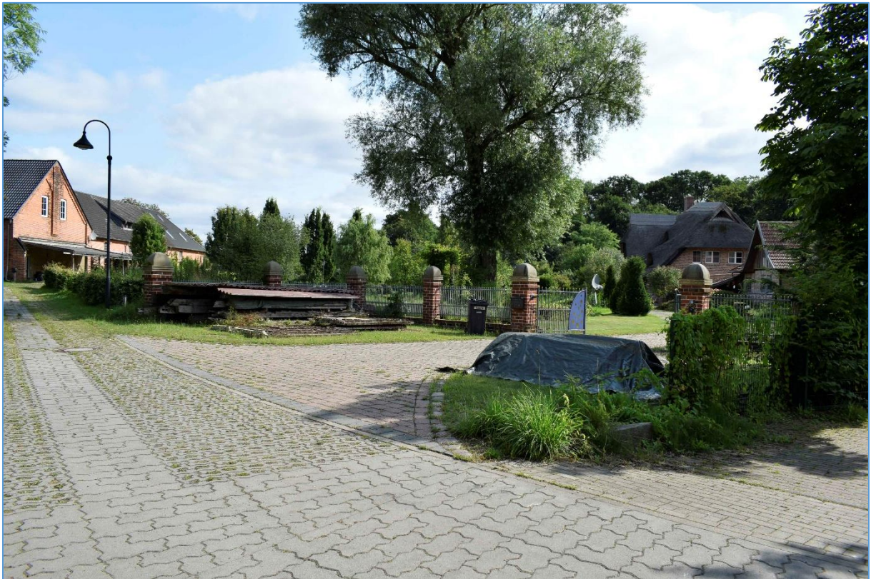
Neuhof, Gemeinde Zarrentin (Lkr. LUP), Gutsanlage © LAKD M-V/LD, B. Dräger-Kneißl 2024.
