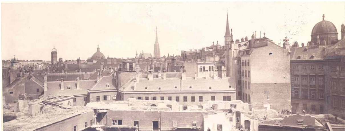
Abbrucharbeiten am Minoritenplatz
